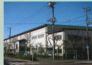
本社・川崎工場
